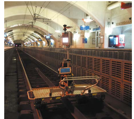
Chariot Leica ProScan monté sur lorry - Gare Haussmann Saint-Lazare - 2017
