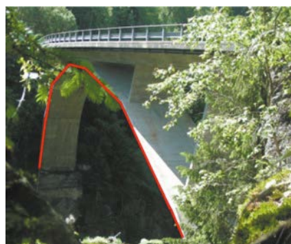
Figure 6. Pont sur l'Eau Noire (Valais)
