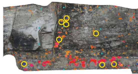
Figure 35. Inspection E0 - E1 (cercles jaunes = zones en mouvements)
