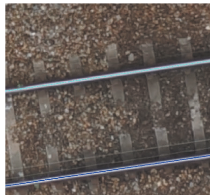
Figure 12. Files de rails détectées (sans échelle)
