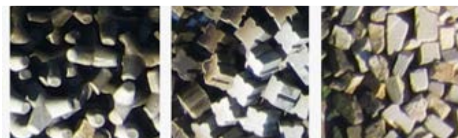
Figure 8. La digue d'Ericeira et les différents matériaux de surface (A : tétrapodes, B : cubes Antifer, C : blocs de pierre, Q : jetée et superstructure en béton)
