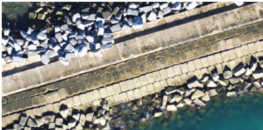
Figure 7. Détail de l'ortho-mosaïque sur la digue est de Portimão, un parallépipède 2 m x 3 m
