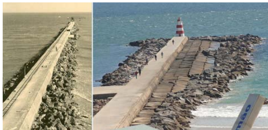
Figure 5. Digue ouest à Portimão (à gauche en 1952 pendant la construction, à droite en 2012 après les travaux de consolidation)
