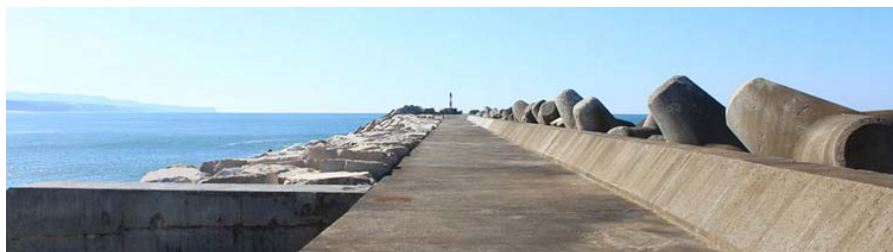
Figure 4. Digue d'Ericeira, superstructure flanquée de blocs de pierre et, côté mer, de tétrapodes
