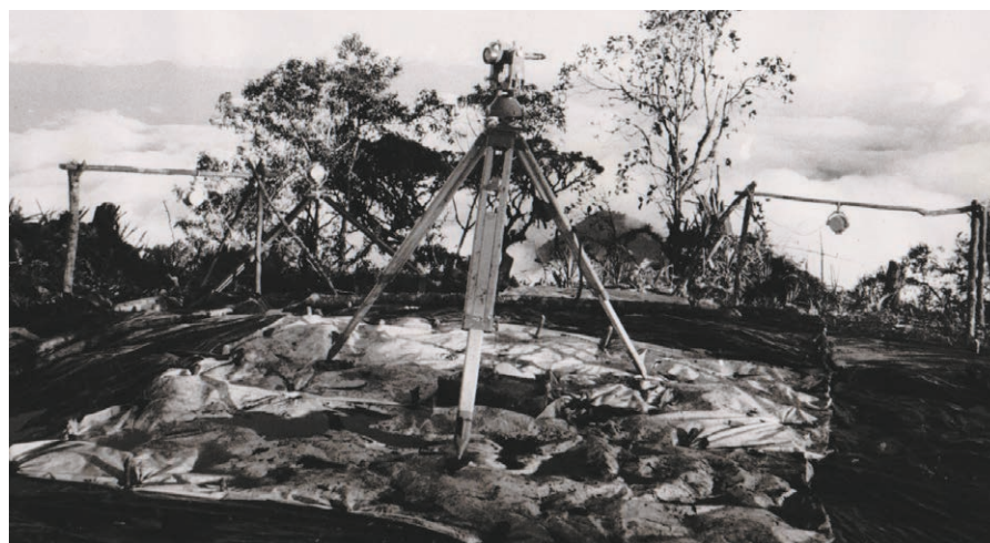
Figure 6. Mesure d'angles au théodolite WILD T3 sur projecteurs.
