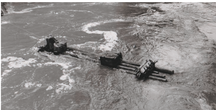
Figure 12. Le matériel traverse le rio.
