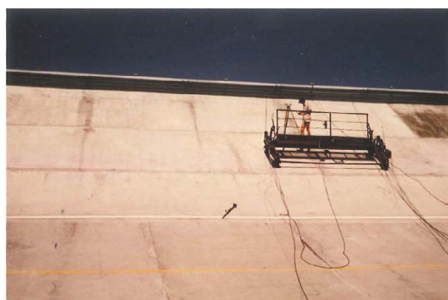
Figure 6. Nivellement direct d'un profil en long
