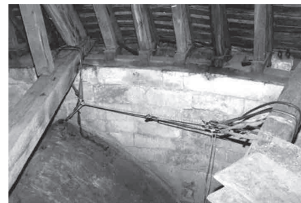
Figure 8. Nos amarrages aux poutres de la charpente, pour arriver à la verticale des trous.
