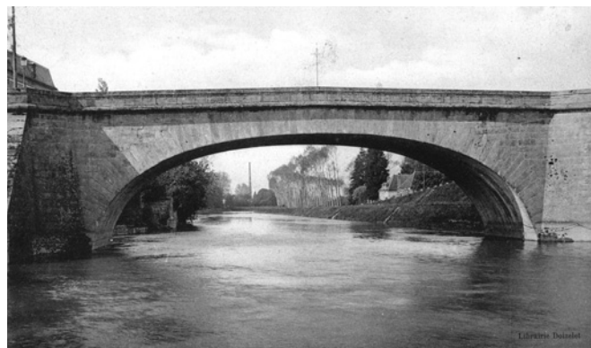
Fig. 5 : Le pont Saint-Edme à Nogent-sur-Seine (Aube), construit par Perronet pour la route royale de Paris à Bâle (RN 19). Devant le précarité d'un ancien pont à quatre arches, pourtant construit depuis seulement une quarantaine d'années, Perronet fit construire un peu plus en aval, d'octobre 1766 à octobre 1768 (décintrement), un nouveau pont d'une seule arche en anse de panier de 90 pieds d'ouverture (29,24 m). Il a été détruit par les Allemands lors de leur retraite, le 26 août 1944 et malheureusement n'a pas été reconstruit à l'identique, un peu plus large certes, mais avec des brisures aux naissances de la voûte.
