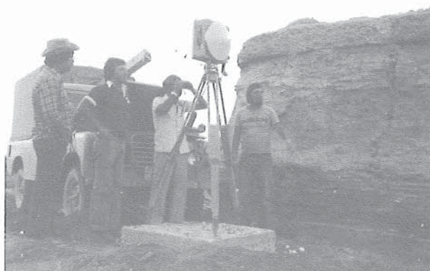
Canevas de rattachement. Mesures angulaires au Théodolite WILD T 2.
