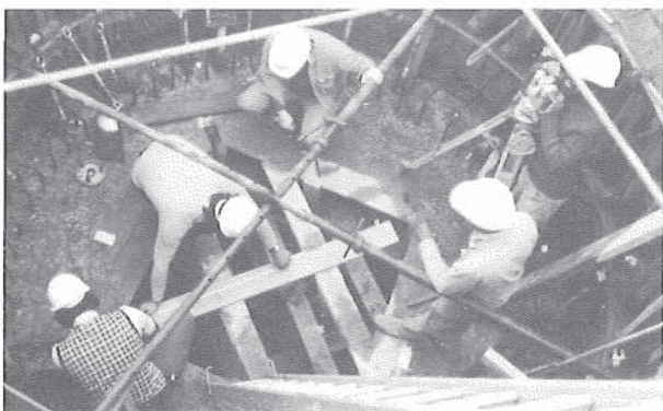
Radier d'îlot nucléaire. Surveillance de la nappe phréatique. Nivellement géométrique par cheminement.
