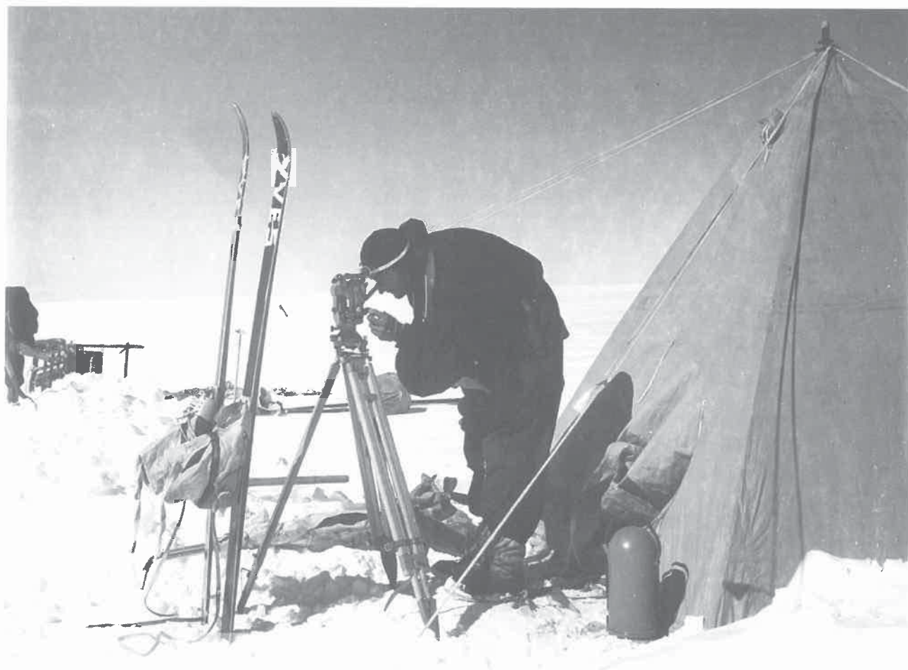
Au théodolite T2 - Le raid sur le plateau. On fait le point sur le soleil. Photo Y. Vallette - Cliché Expéditions Polaires Françaises
