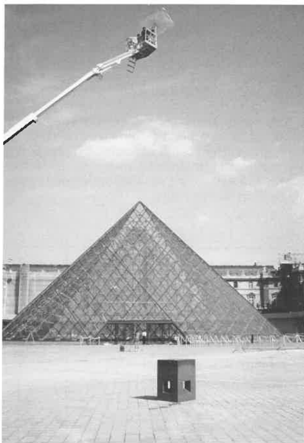
Planche 1. Le contrôle photogrammétrique de la planéité des faces.
