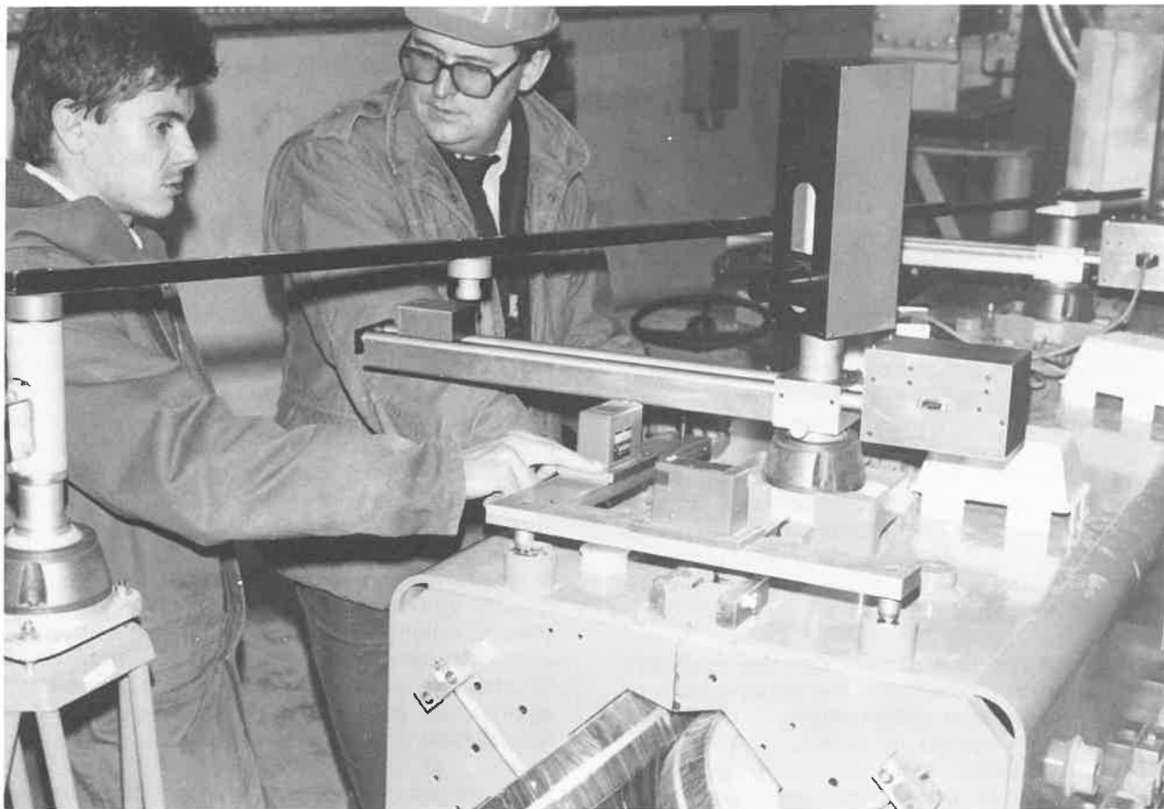
Photo 1 : Installation d'un quadripôle du LEP, sous contrôle informatique
