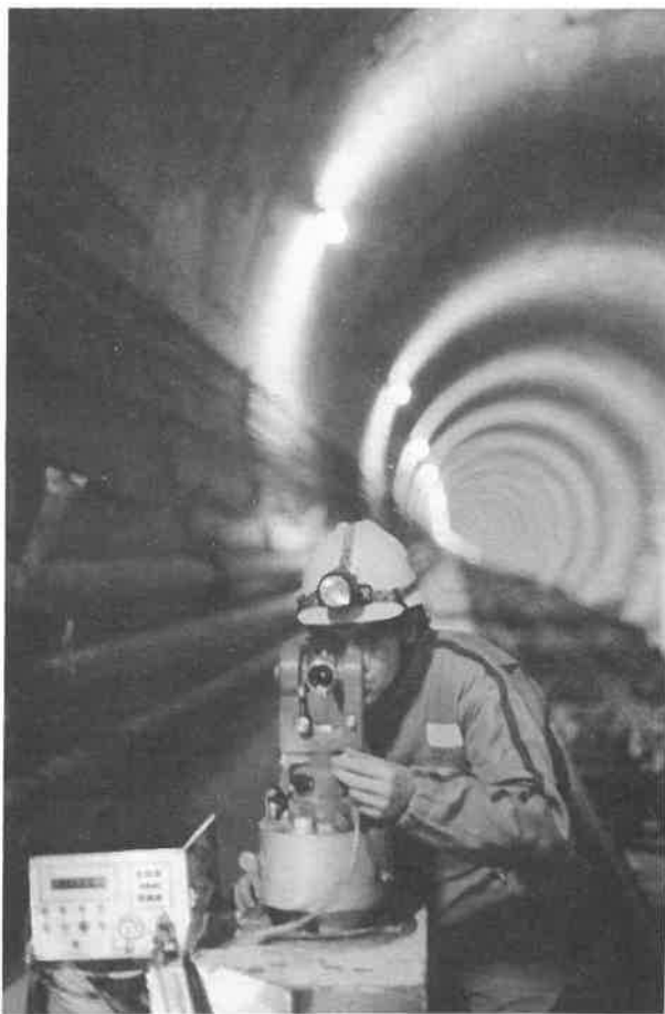
Tunnel ferroviaire. Gyrothéodolite (Gyromat et T2 Wild).
