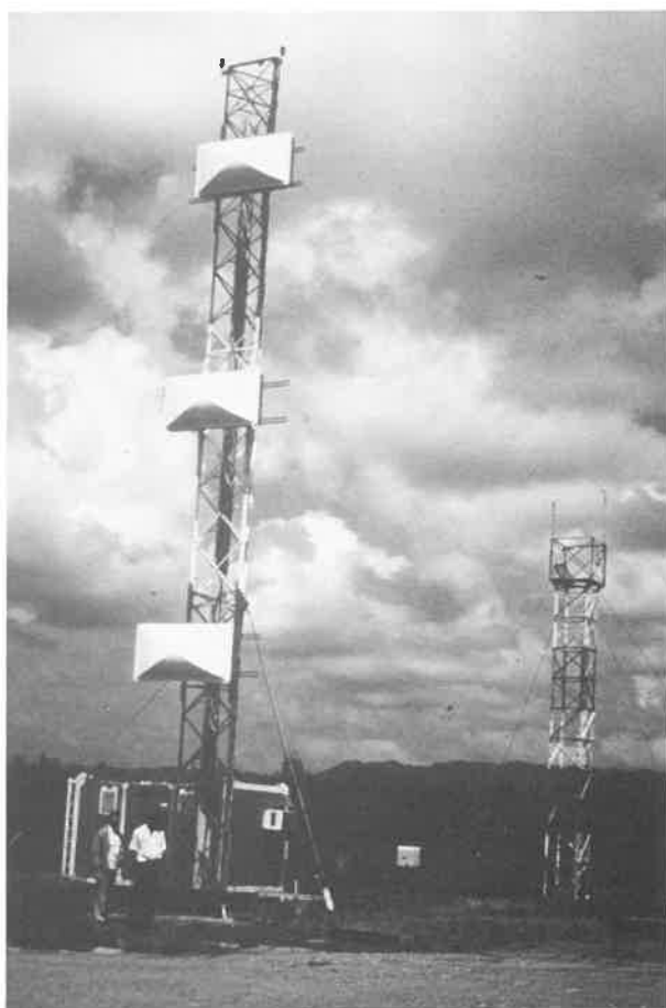
Radioalignement de descente - Equipement radioélectrique d'aide à la navigation aérienne - Aérodrome de Fort de France - Photothèque du STBA
