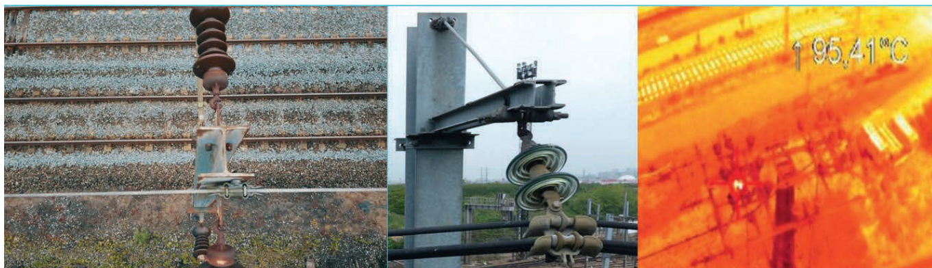
Figure 20. Visite d'installations caténaires à l'aide de drones
