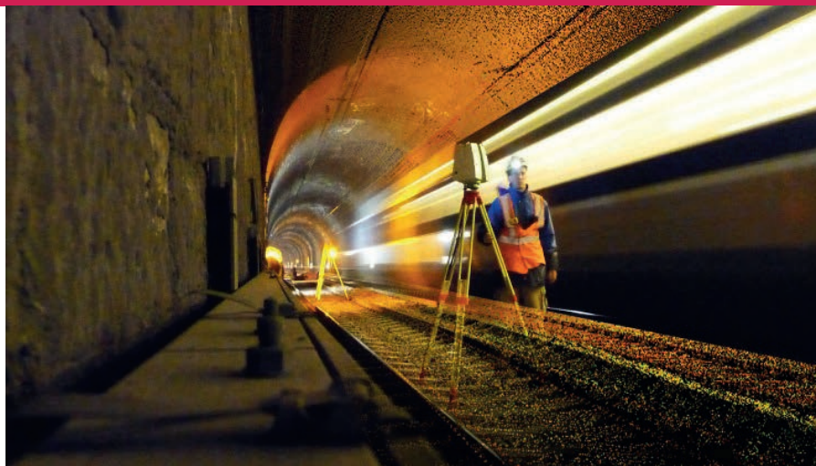
Figure 10. Réalisation d'un relevé d'un tunnel en travaux
