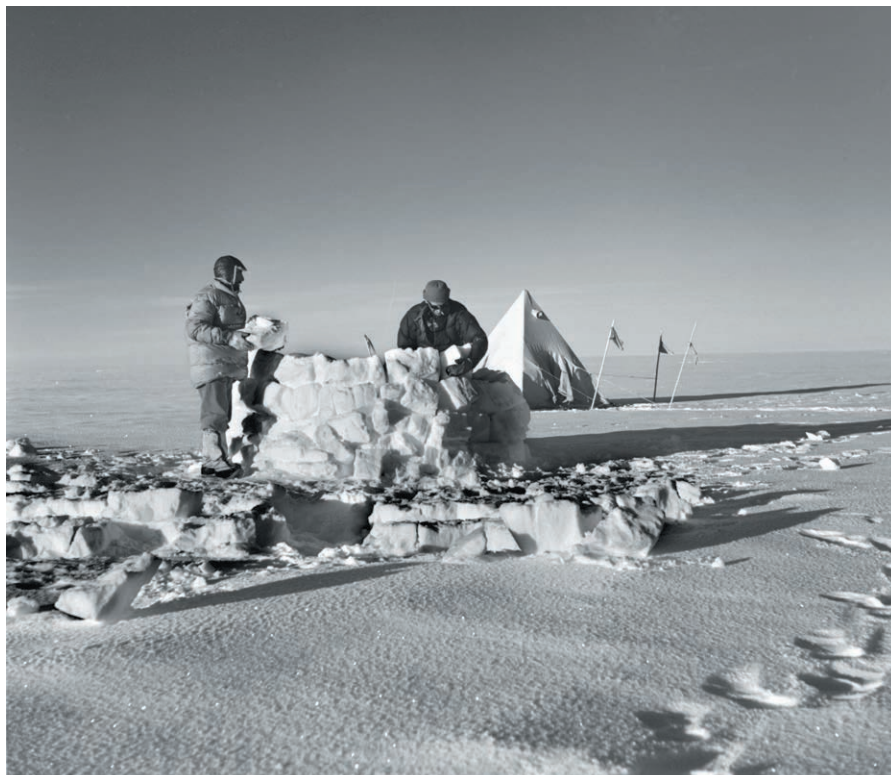
Photo 5. Riquer et Grisoni construisent un igloo au Terme Nevière, à 2850 m d'altitude, le 6 juillet. En arrière-plan, une tente pyramidale dont le trou d'homme, orienté sous le vent, est balisé par des fanions.
