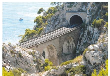
Il fallut attendre le XX<sup>e</sup> siècle pour voir le béton armé sur de grandes portées, ici le pont sur l'Artuby (Var). En 1904, les viaducs de la nouvelle voie ferrée de Marseille à Martignes sont toujours en pierres taillées.
