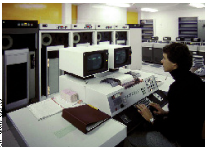
Un ordinateur IRIS 80, à la fin des années 1970. Les résultats sont stockés sur bandes magnétiques, mais les cartes perforées, à gauche de l'opérateur, sont toujours employées pour le traitement des données. Les écrans ne permettent que de visualiser les instructions et résultats chiffrés. Pas de souris, les commandes se font au clavier.
