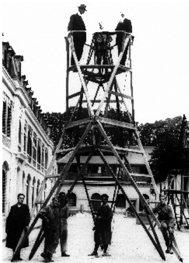
Photographie montrant un tripode Ragué, utilisé en géodésie, monté dans la cour du Service Géographique de l'Armée, 136 rue de Grenelle, avant la création de l'IGN.
