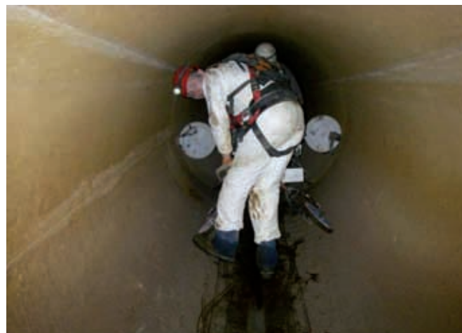
Figure 11. Topographe en inspection de conduite, avec GIPSI.
