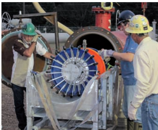
Figure 10. Introduction du racleur dans le pipeline.
