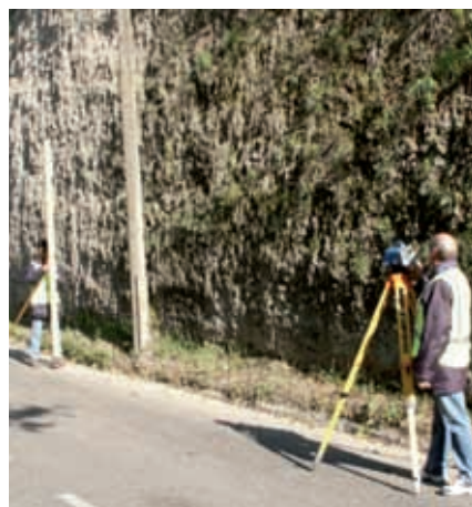
Figure 5. Nivellement de précision sur la route de Bellet à Nice (Opérateur M. Bernard Laugier, porte-mire M. Marc Sulis)
