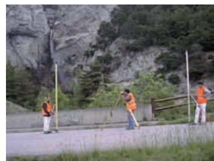
Figure 5. Mesures de nivellement - Aussois.
