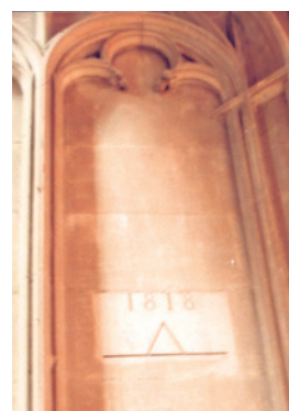
Le repère du nivellement géodésique de la cathédrale de Bourges
