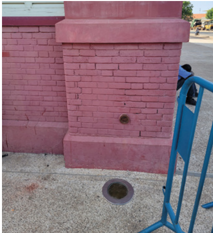
Photo 1. Repère situé sur le pilier sud-est du bâtiment de la gare de Dakar.
