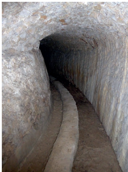
Figure 2 et 3. La conduite dallée (0.3 m) est moins onéreuse qu'une galerie.
