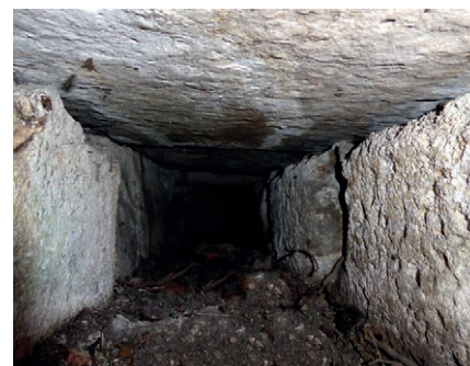
Figure 2 et 3. La conduite dallée (0.3 m) est moins onéreuse qu'une galerie.
