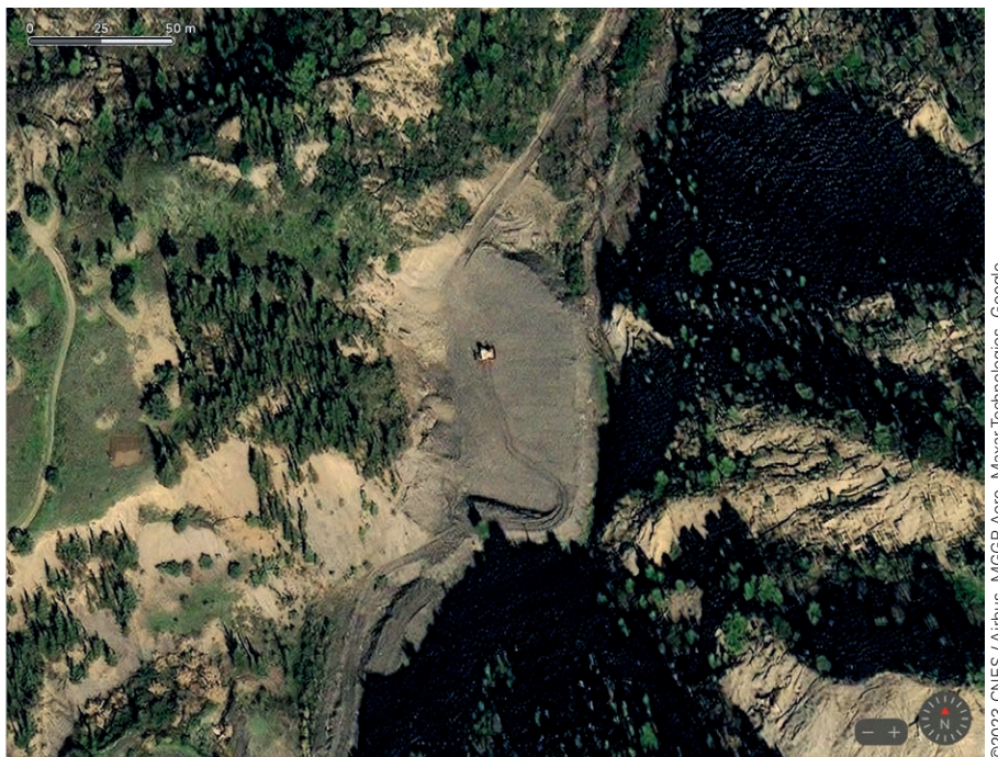
Figure 3. Le stade en construction.
