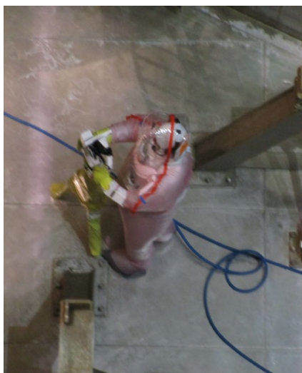
Figure 6. Protection du matériel de photographie 360° pour les accès en fond de piscine du réacteur, réalisés en tenue étanche ventilée.
