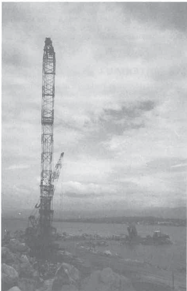
Construction de la digue du Port de Grande Plaisance à Antibes.
