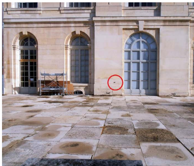
Figure 1. Repères de nivellement disponibles dans le parc de l'Observatoire de Paris. Ils portent les matricules P.A.A3B3-41 et P.A.A3B3-42.
