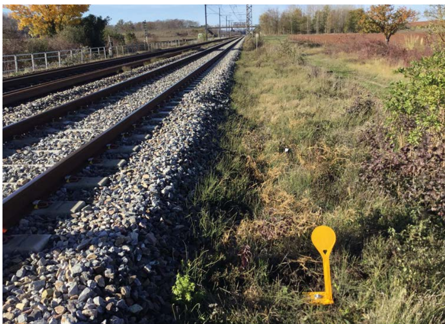
Figure 1. Une borne aux abords d'une ligne ferroviaire
