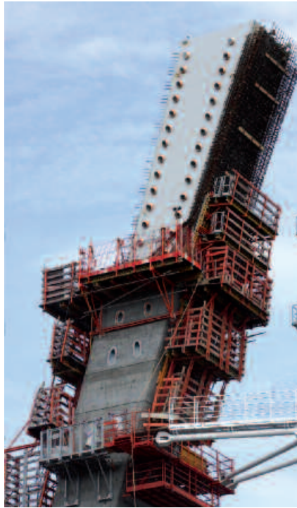
Levage de la boîte d'ancrages
