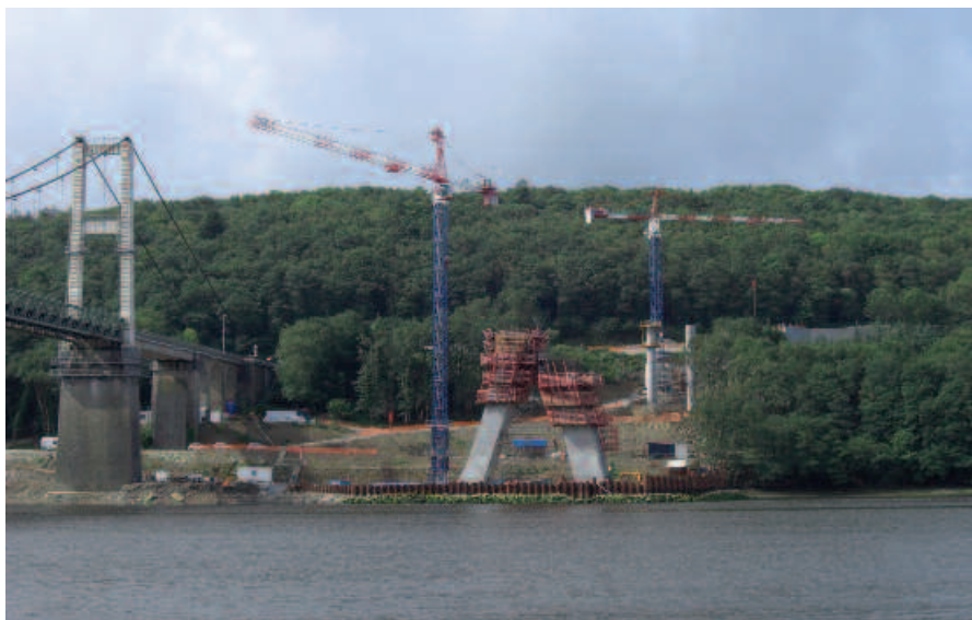
Construction du pylône
