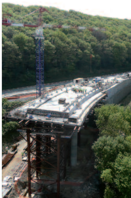
Tronçon de tablier de rive construit sur cintre
