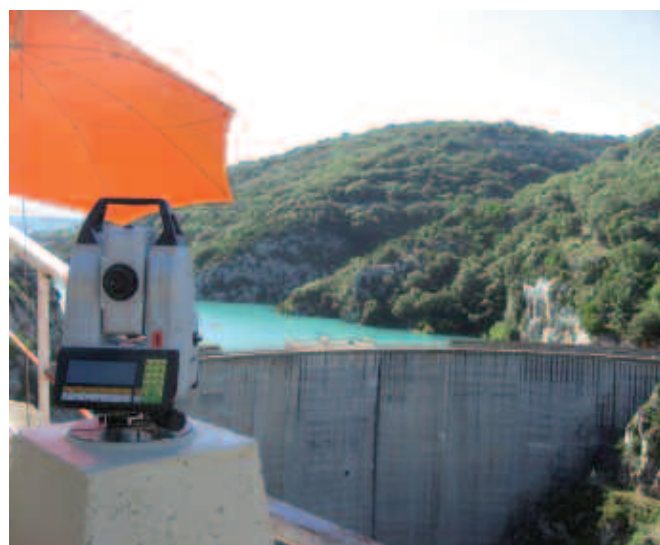
Figure 6. Auscultation automatisée d'un barrage
