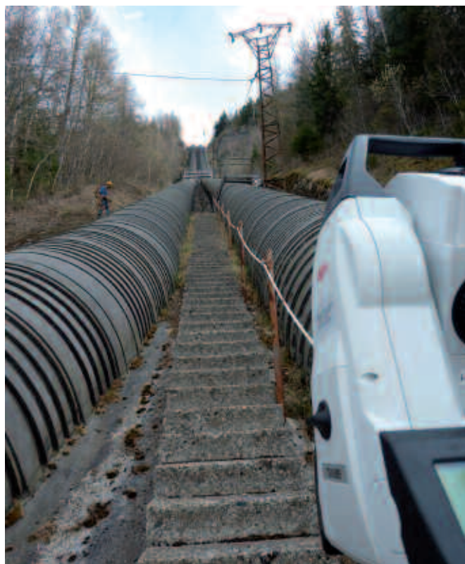
Figure 9. Auscultation d'une conduite forcée
