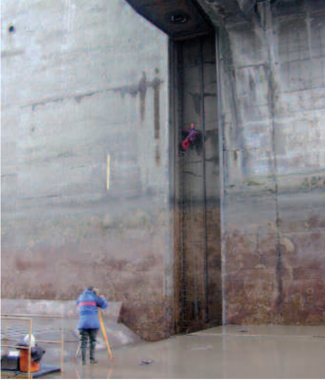
Figure 12. Relevé 3D sur la porte d'une écluse
