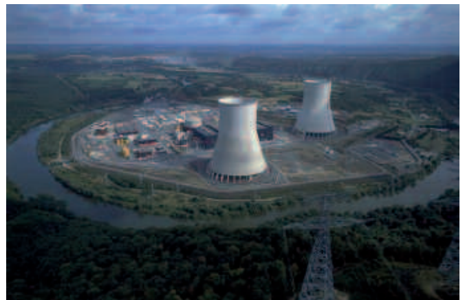
Figure 15. Aéroréfrigérants d'une centrale nucléaire
